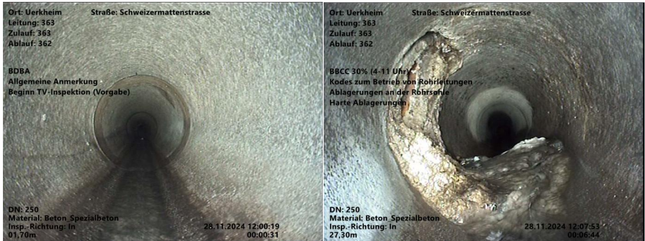
Abb. Nr. 3: Freie Fliessstrecke und eingespitzter Anschluss
