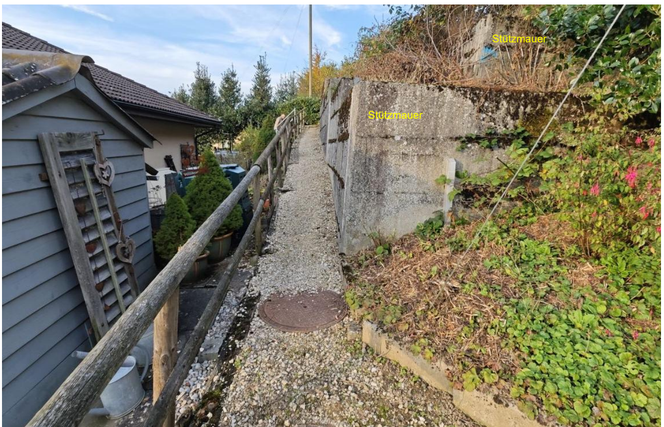
Abb. Nr. 2: Foto Fussweg entlang der Stützmauer
